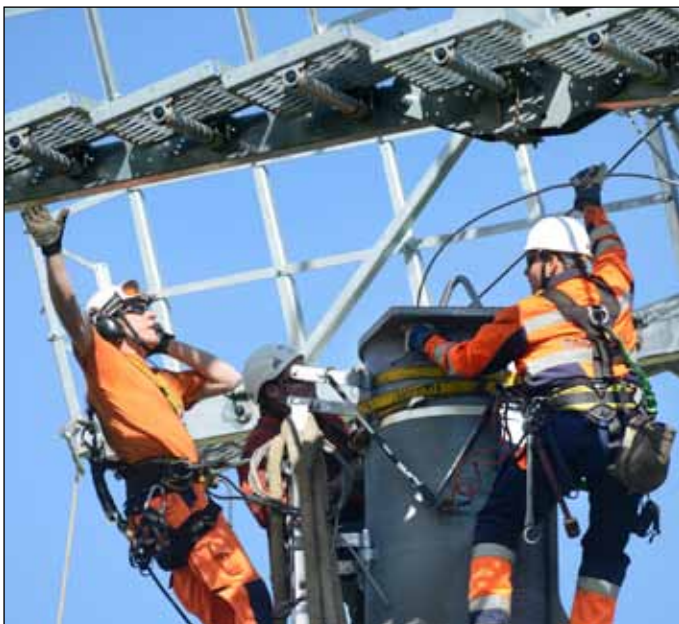
15 der insgesamt 17 Masten wurden „in einem Zug“ aufgestellt
