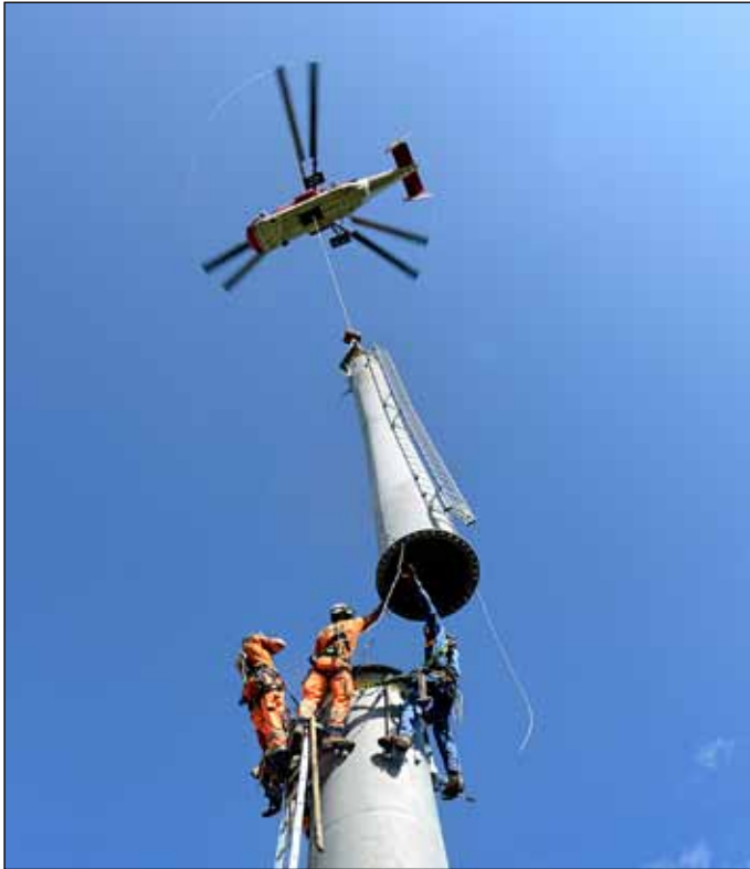
„Kran der Lüfte“: Der Kamov KA-32A12 von HELISWISS
